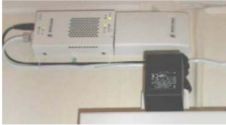
รูปที่ 8 ภาพตัวอย่างแสดงจุดต่อและแยกสายของเคเบิลเส้นใยนำแสง (ภาพบน) และอุปกรณ์ ONU ภายในอาคาร (ภาพล่าง)
